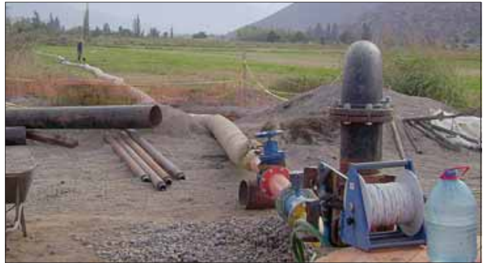
Este domingo las pruebas permitieron comprobar que el pozo entrega 24 litros por segundo, por lo que cumple para entrar en funcionamiento en un 100%.
