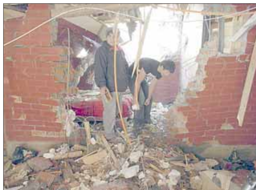
Así quedó esta vivienda en Río Blanco, luego que una enorme roca ingresara pesadamente a su interior y destruyera todo a su paso.
