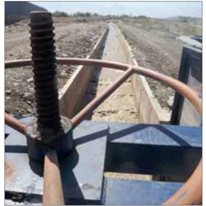
Aunque al arribo de Diario El Trabajo a la Villa 250 Años, el canalón tenía poco caudal, los vecinos aseguran que durante la madrugada el tema fue preocupante.
