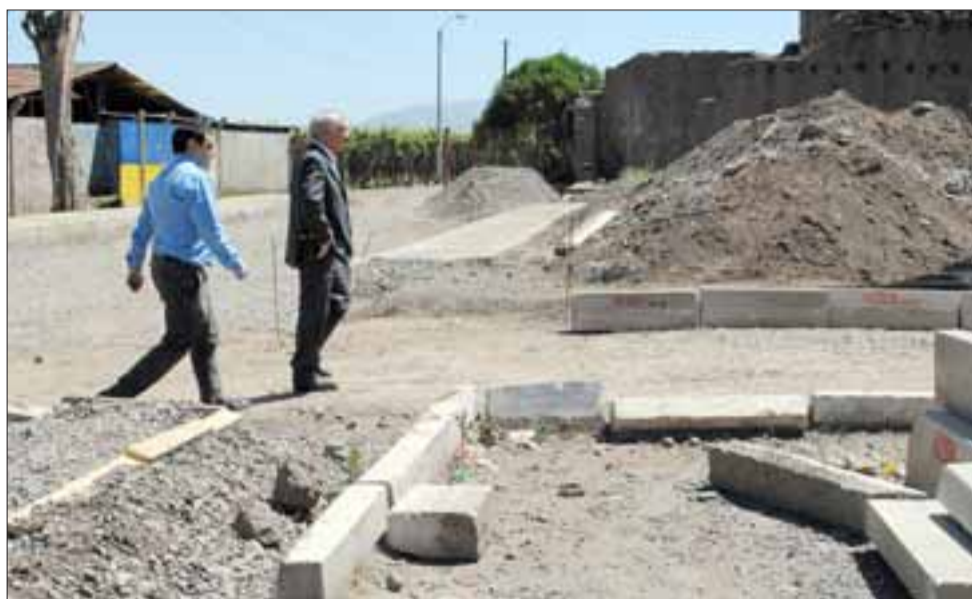
En algunos sectores los trabajos recién están comenzando, pero gracias a la organización de los vecinos muy pronto serán realidad.
