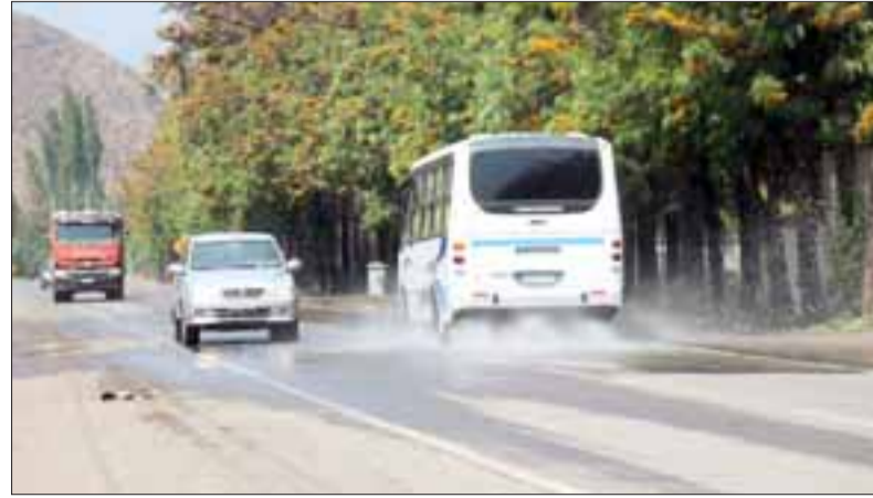
Una situación bastante riesgosa se vive en el sector Las Coimas debido al desborde del canal de regadío que corre paralelo a la ruta.
