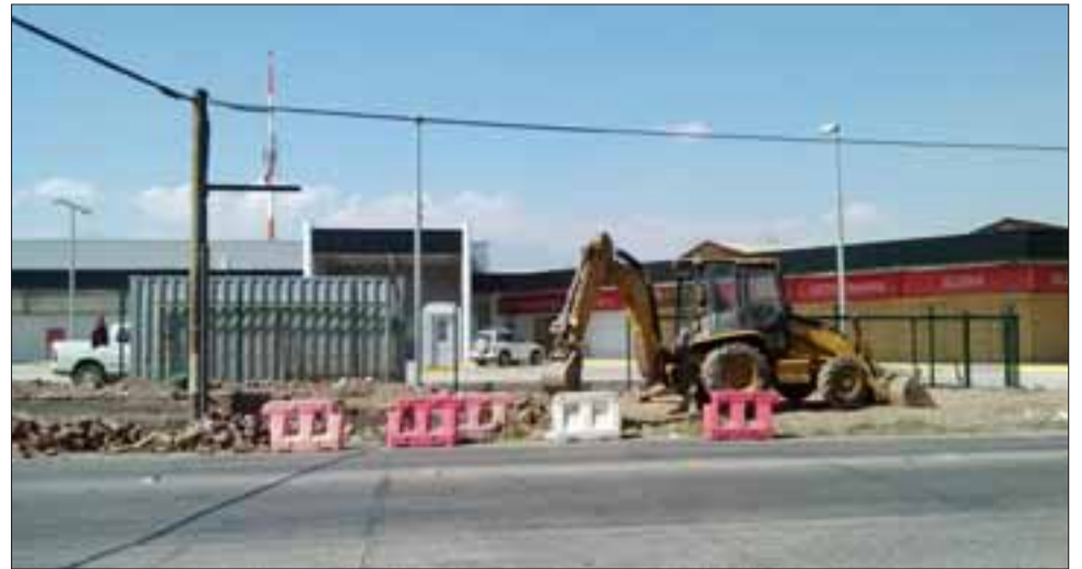
Ya este fin de semana se reiniciaron los trabajos en el centro comercial de Encón, debiendo estar operativo en el mes de noviembre.
