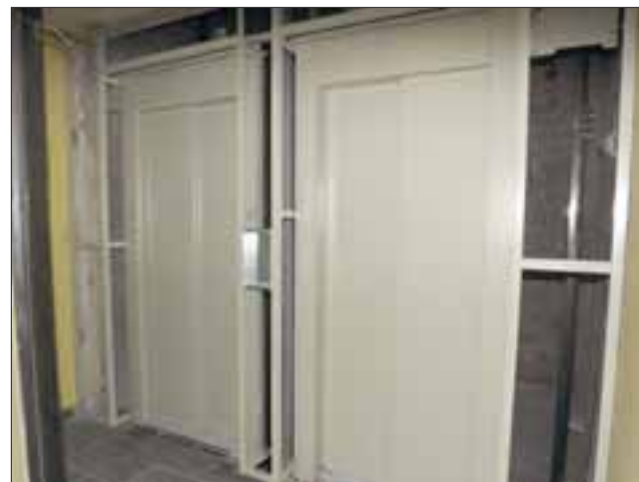
Los nuevos ascensores de la Gobernación Provincial de San Felipe se pondrán en funcionamiento a más tardar, a fin de mes.
