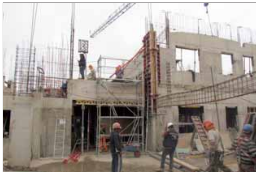
Así de avanzada se ve la construcción del Cesfam Centenario después de tan sólo unos meses de comen-
