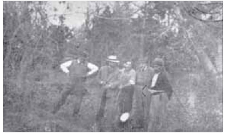
Oficiales de la Policía Civil junto al empleado que enterró clandestinamente el cuerpo de Demetrio Amar. Los hombres se disponen a comenzar la excavación.
