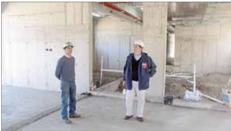
Tras la última evaluación realizada a las obras del Cefsam Eduardo Raggio, el equipo del Servicio de Salud Aconcagua informó que los trabajos ya superan el 70% de ejecución.
