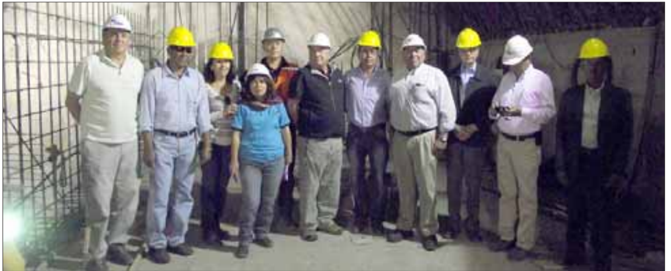
En el marco de una invitación realizada por la Junta de Vigilancia del Río Putaendo, la directiva de sus pares del Río Lluta de la ciudad de Arica visitó las obras de construcción del Embalse Chacrillas.
