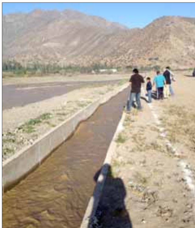
El 'Canalón de la Vergüenza' se llenó de agua, coincidiendo con la entrada en vigencia del decreto de Escasez Hídrica...
