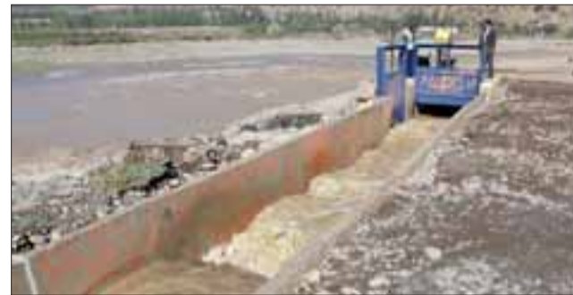
La compuerta lateral es la que fue cerrada -quien sabe por quién- y produjo el desborde del canalón.
