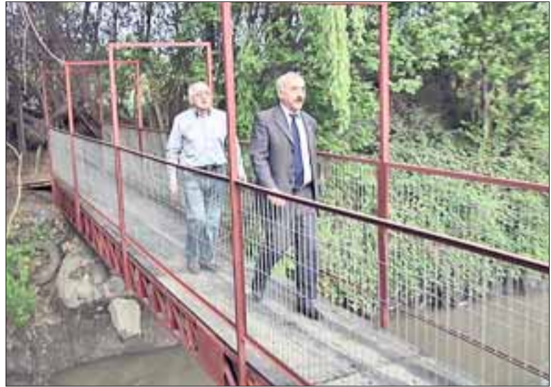
La actual pasarela, realizada con recursos propios por el municipio, viene a satisfacer una real necesidad para la gente del lugar.
