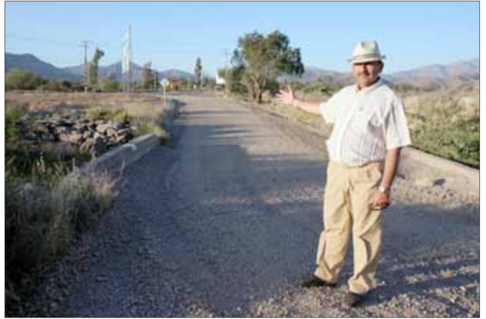
En este lugar se habilitará el acceso para camiones, lo que generará un grave riesgo, advirtió el Concejal Carlos Gallardo.
