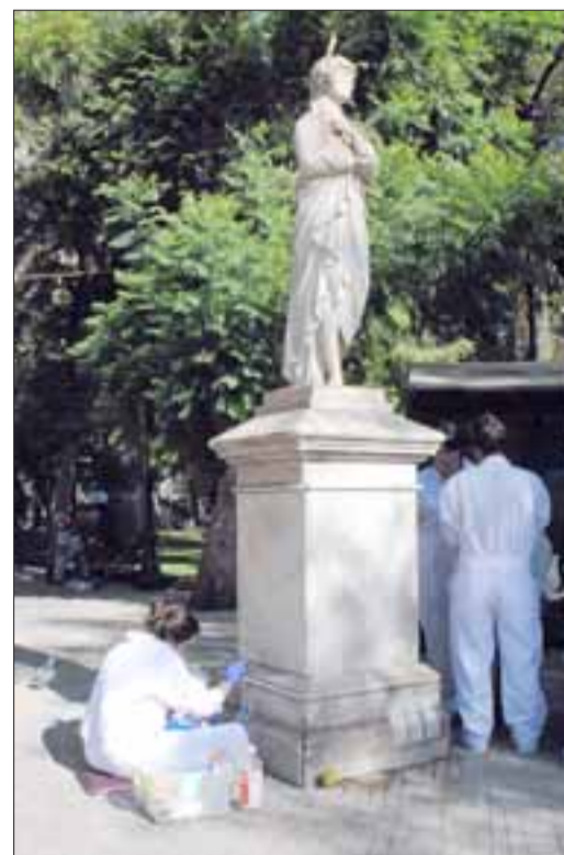
Este martes comenzaron los trabajos por parte de la empresa a cargo de la restauración de cuatro esculturas de la plaza.
