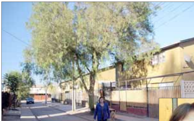
Este árbol en el Pasaje Abrazo de Maipú de la Población Doña Javiera Carrera, que origina serios inconvenientes eléctricos a los vecinos del sector.
