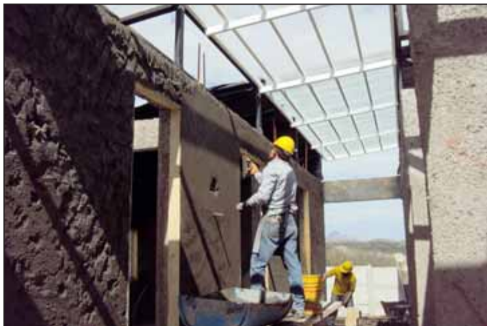
La remodelación de la posta Santa Filomena cuenta con 300 metros cuadrados de construcción que se encuentra en plena etapa de desarrollo.
