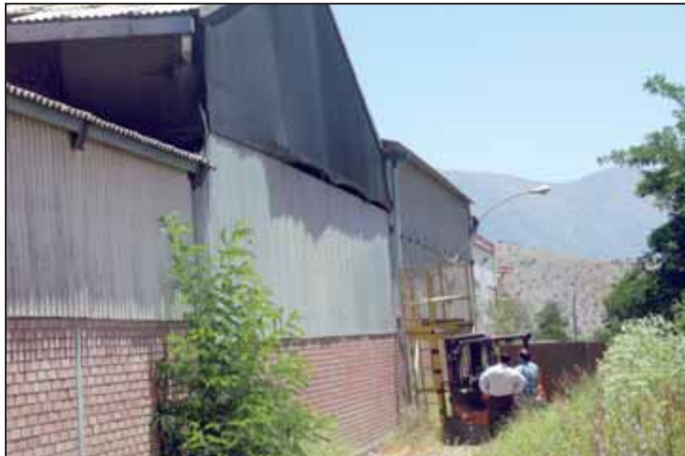
Los trabajadores ascendieron hasta la techumbre del galpón por medio de esta grúa horquilla aparentemente sin medidas de seguridad para realización de labores de limpieza.
