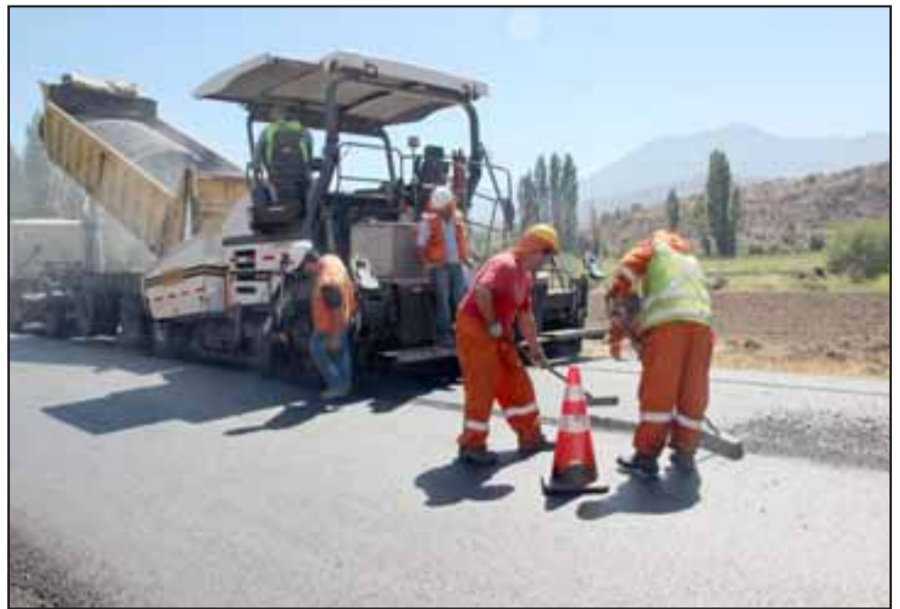
Cuando este camino sea entregado quedarán en el olvido los desniveles entre una pista de cemento y una de asfalto.
