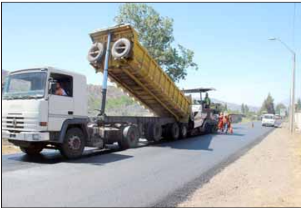
Bastante adelantados se encuentran los trabajos de recarpeteo asfáltico en la Carretera E-71 que une Putaendo con San Felipe.
