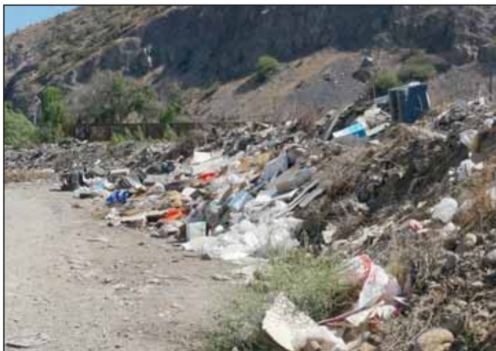
Son cientos de toneladas de escombros y basura los que descansan sobre el trazado de la nueva carretera.
