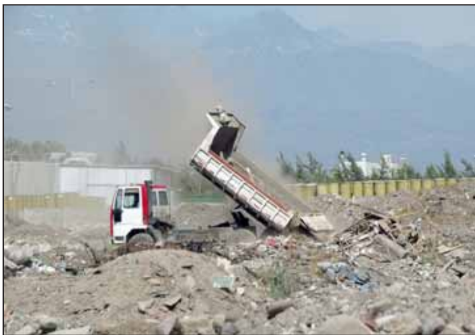
Esta foto captada hace solo unos días, muestra como todavía se siguen vertiendo escombros y basura aún a plena luz del día.
