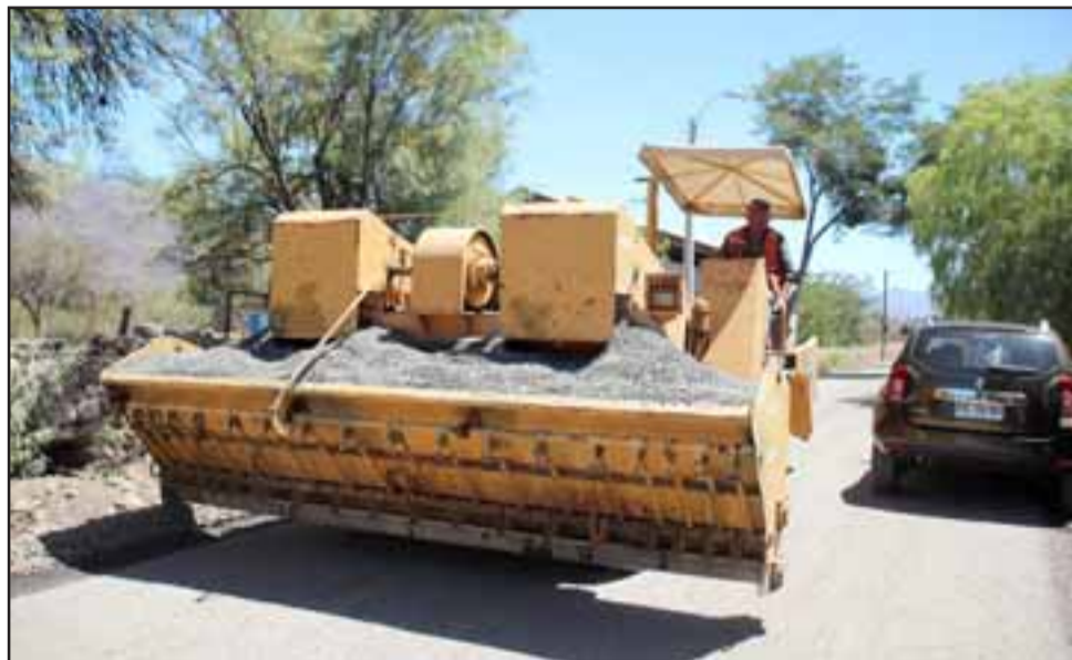
En su etapa final se encuentran los trabajos de mejora y asfalto de las calles El Gancho y El Peral, que unen el sector Las Compuertas en Quebrada Herrera con Calle Los Álamos de Granallas.
