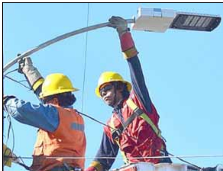
En la comuna de Panquehue se efectuará el recambio de 651 luminarias, lo que significa un importante ahorro para el municipio.
