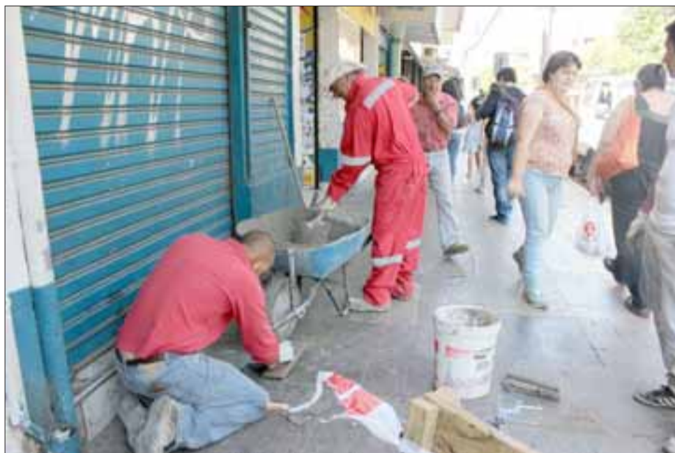
En Calle Combate de las Coimas, frente a la Plaza de Armas, fue posible apreciar a personal municipal realizando trabajos de tapado de eventos de las veredas.
