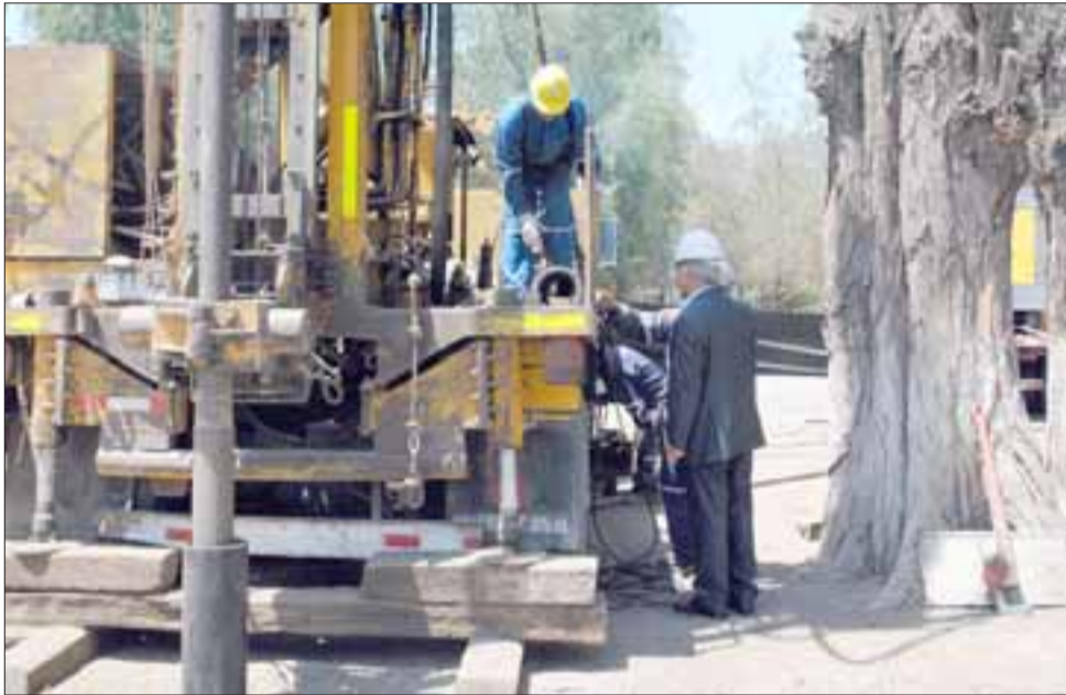
Con la construcción de estos pozos, los estadios fiscal y municipal y la plaza de armas podrán contar con alrededor de 20 metros por segundo de agua por segundo.
