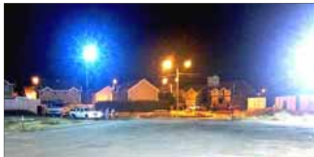
Los 23 nuevos proyectores fueron instalados gracias a un proyecto elaborado por el municipio andino.
