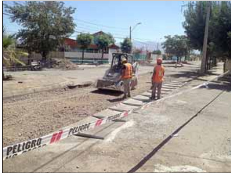
Pavimentos, construcción de lomos de toro e instalación de señalética vial, está ejecutando la Municipalidad de Los Andes.
