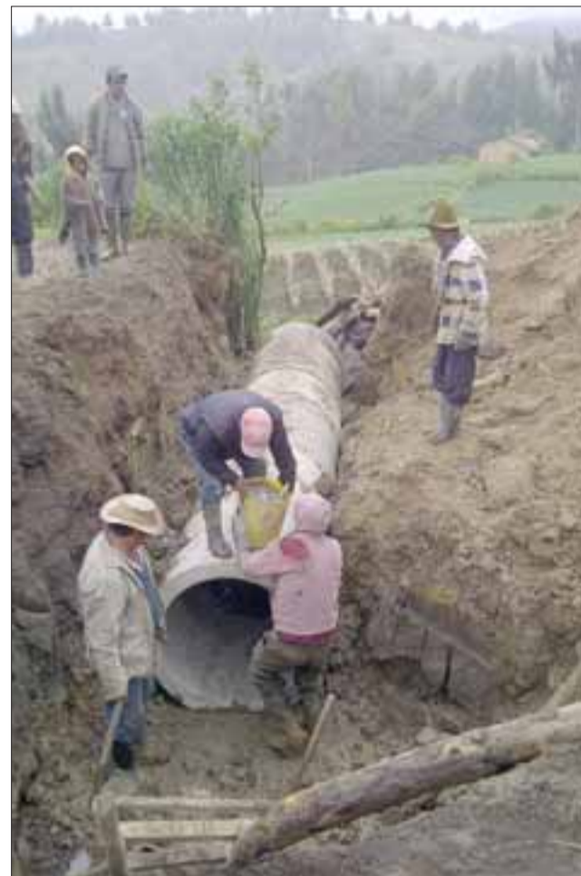
El Gobierno Regional de Valparaíso aprobó la suma de $1.800.000.000 que permitirá el inicio de las obras de construcción del nuevo alcantarillado para Piguchén. (Archivo)
