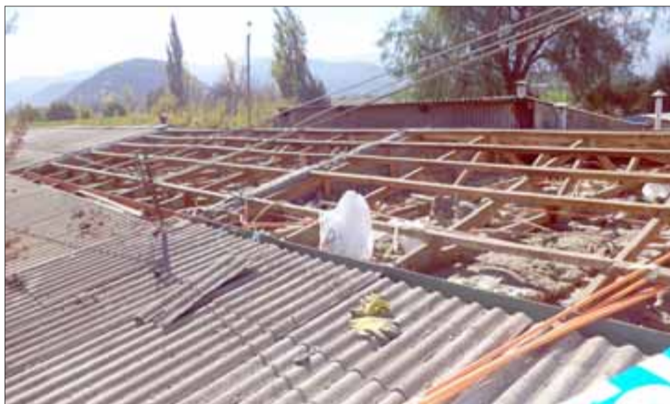
NO MÁS GOTERAS.- Felices se encuentran los vecinos de Villa Las Acacias, en sus distintas etapas, pues también la techumbre de sus casas ahora están siendo reparadas.
