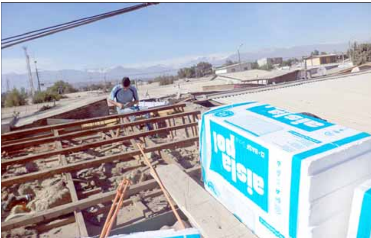
REPARACIONES VALIOSAS.- Además, la dirigente agradeció el trabajo de la Oficina de Vivienda de la Municipalidad de San Felipe y a sus profesionales, quienes participaron en el proceso de mejoramiento de las viviendas.
