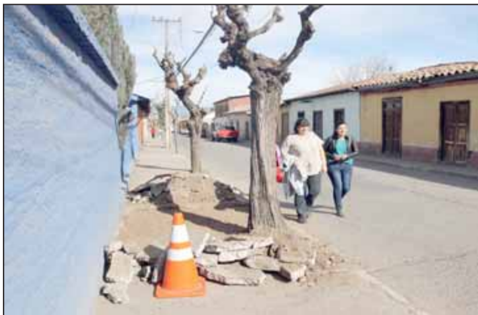
En lo inmediato, estos trabajos permitirán reparar los puntos más críticos de veredas en mal estado, además de rebajar y nivelar las diferencias de hasta 8 centímetros entre un bloque y otro.
