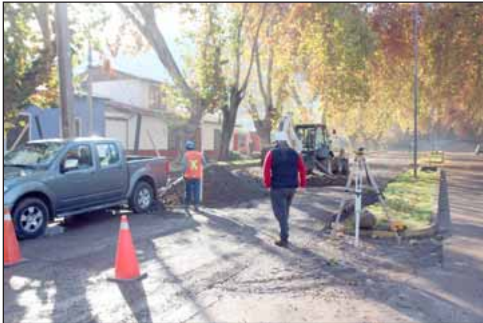
POR FIN.- Desde este lunes comenzaron los trabajos de asfalto en un tramo de Alameda Alessandri frente a Villa La Florida, trabajos que eran ampliamente esperados por los vecinos del sector.
