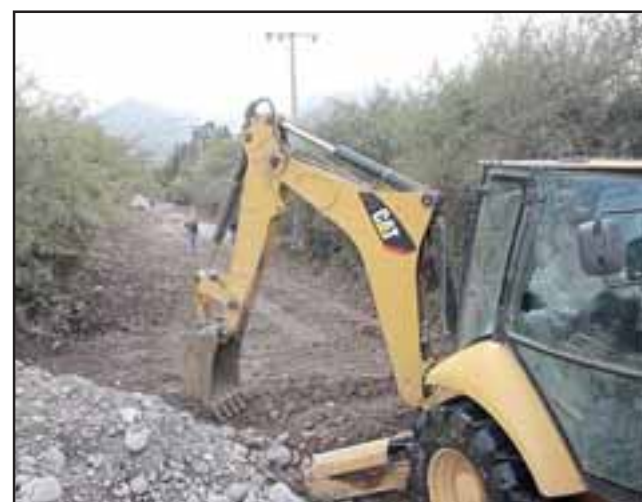
UNIDOS.- Molestos se mostraron los vecinos de Callejón Lo Aranda de Quebrada Herrera, luego que a través de una improvisada colecta tuvieran que reunir el dinero para poder contratar una retroexcavadora.
