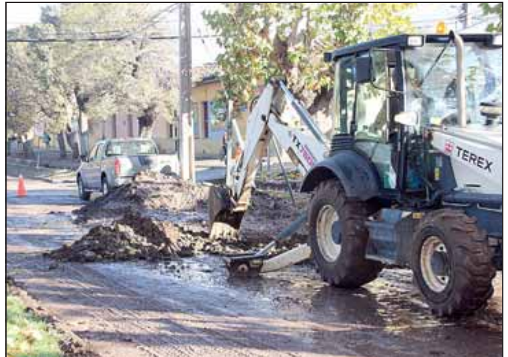
A TODA MÁQUINA.- Los trabajos se desarrollan en una pista de Alameda Alessandri que precisamente está ubicada frente a Villa La Florida, aproximadamente 140 metros lineales y se extenderán hasta la subida del Cerro El Llano.
