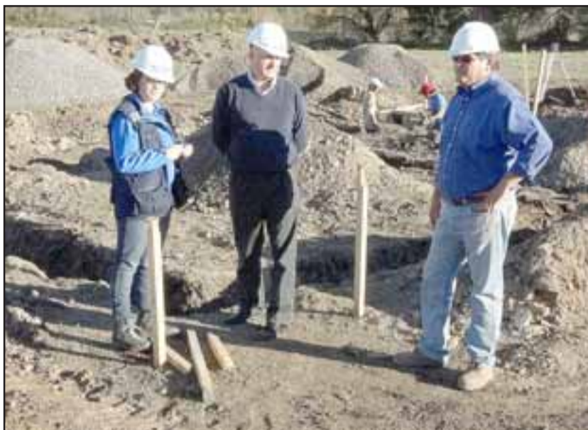
EN PLENA MAR-CHA.- Se trata de la construcción de 242 viviendas que corresponden a los comités habitacionales Esperanza del halcón y Nuevo amanecer.
