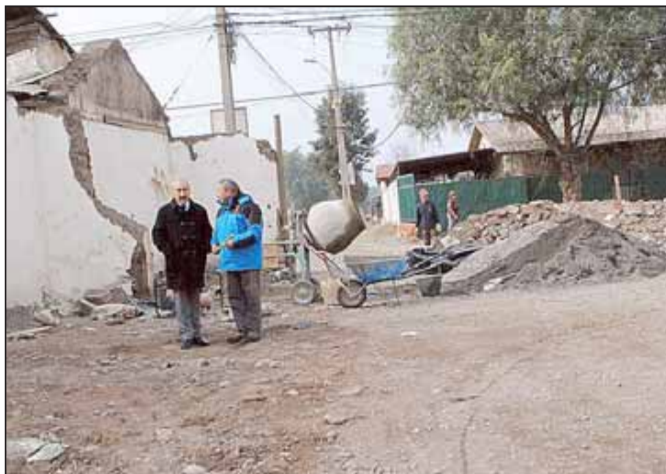
El Alcalde Freire se trasladó en horas de la mañana de este jueves hacia el lugar, para observar el avance de los trabajos, de una iniciativa que se concretó en su administración alcaldía.
