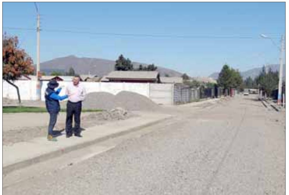
En este momento se pavimentan las últimas tres calles del sector Lo Campo, cuyo total de obras suman $166.834.467.
