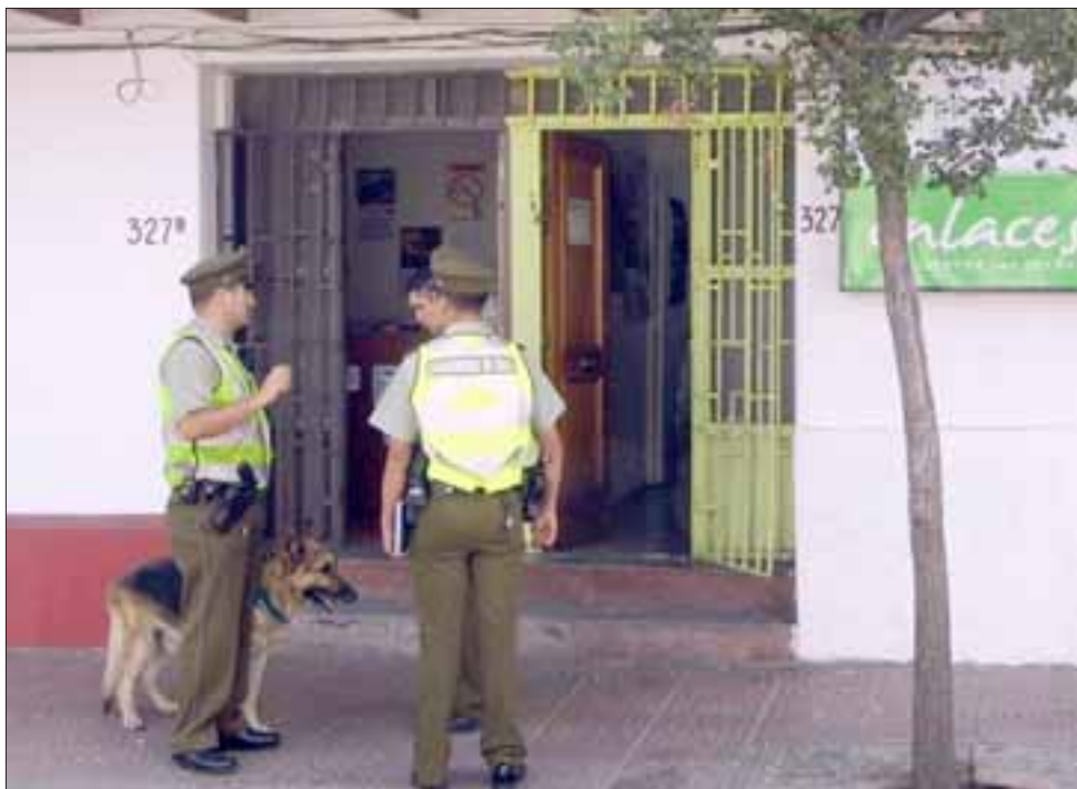
Antisociales sacaron de su base la chapa del candado de la protección metálica de la puerta y luego forzaron la puerta.
