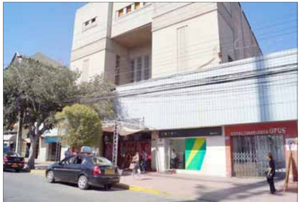
En el caso del Pub 'Opus' de calle O'Higgins, fueron clausurados el segundo y tercer piso que son los salones de baile, ya que no cuentan con la respectiva autorización y recepción por parte de la Dirección de Obras Municipales.
