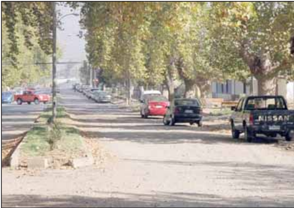
Las obras en una o dos semanas deberían estar terminadas, con una inversión de $15.000.000 con aportes municipales y $4.000.000 de los vecinos de Villa La Florida y del sector aledaño.
