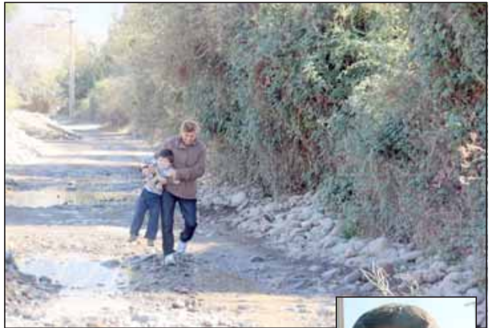
La municipalidad se comprometió a enviar maquinaria pesada para esparcir el material que hoy se encuentra en el Callejón Lo Aranda.
