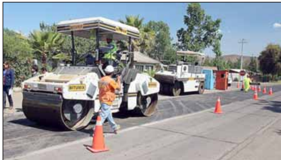
Estas obras que tienen una inversión de $900.000.000 para la reparación del mencionado tramo, que es una de las partes más peligrosas de esa carretera.
