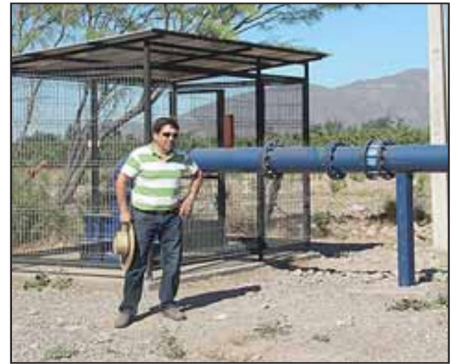
Presidente de la Junta de Vigilancia del Río Putaendo, Miguel Vega, aseguró que hasta la fecha aún no pueden ocupar los pozos por la falta de compromiso de la Dirección de Obras Hidráulicas (DOH).
