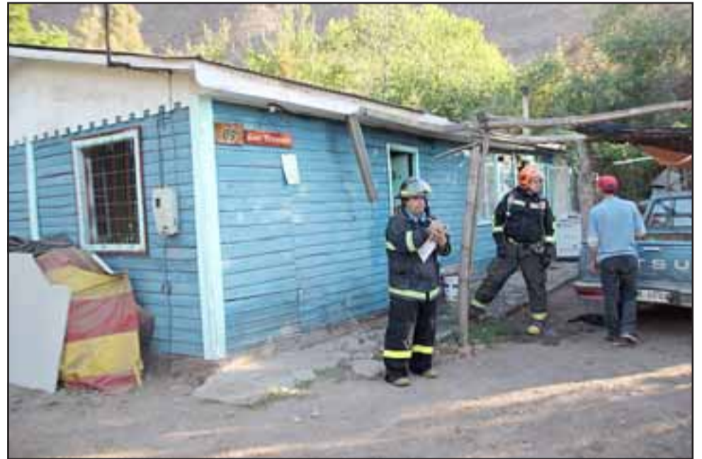
Aparentemente una falla eléctrica al interior de una casa de material ligero ubicada en el sector La Nogalada, en las cercanías de Piguchén, habría sido la causa del incidente.
