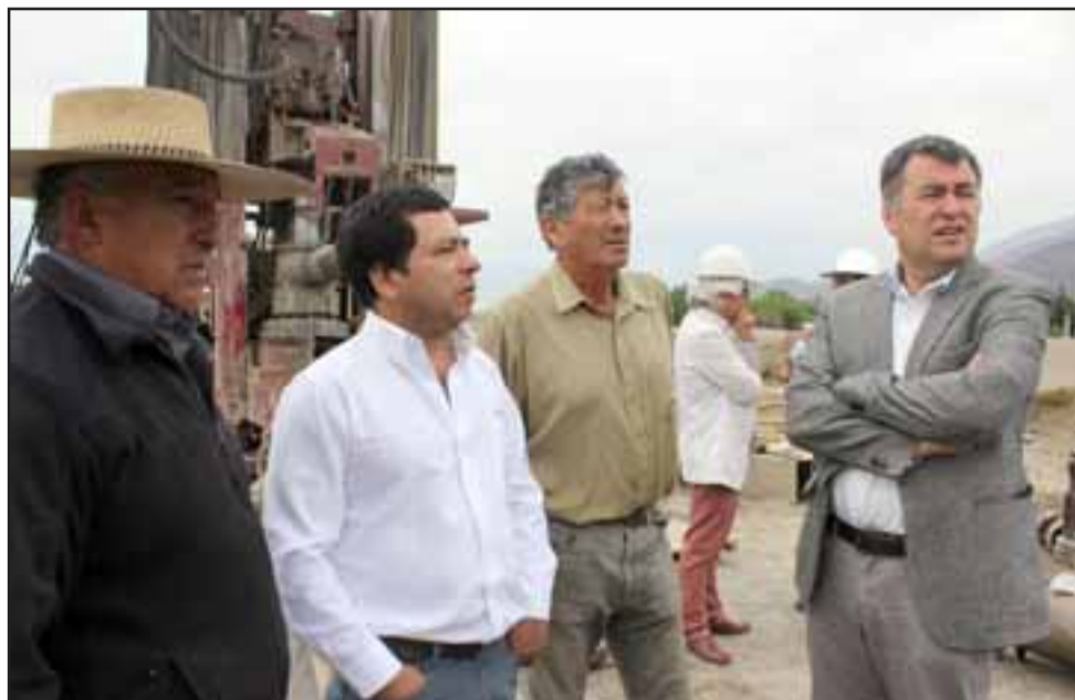
Agua del pozo beneficiará a 1.500 personas y se espera esté terminado el 15 de enero del 2015.
