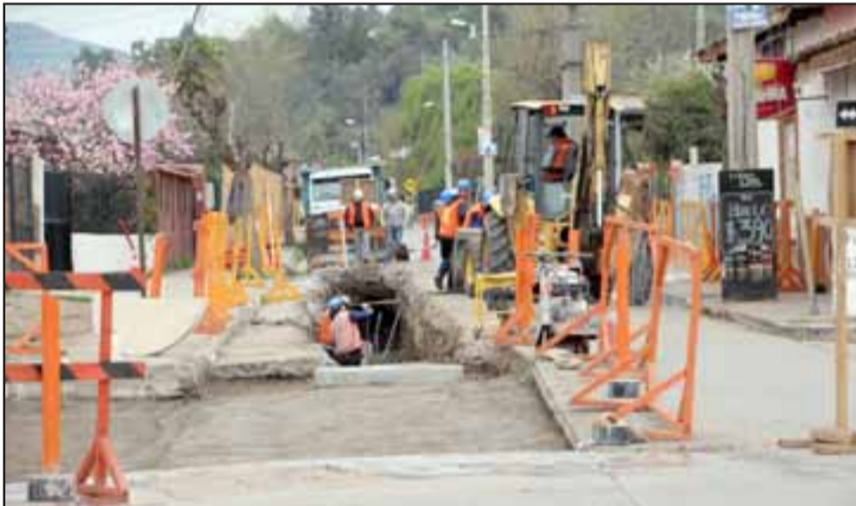
Esva se encuentra realizando la renovación del colector de aguas servidas de Calle Chacabuco.
