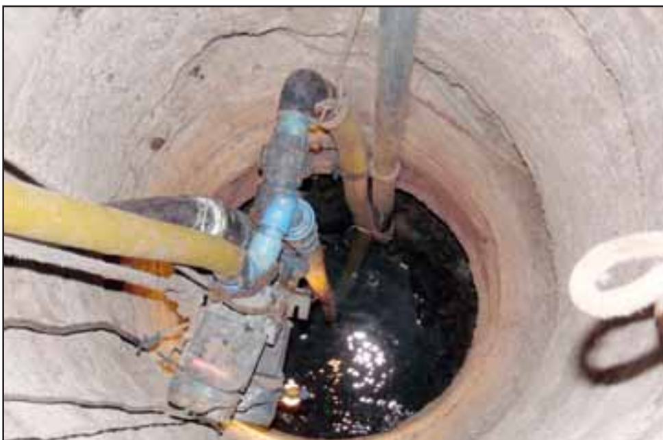
El pozo de Las Tres Canchas debió ser profundizado al secarse completamente.
