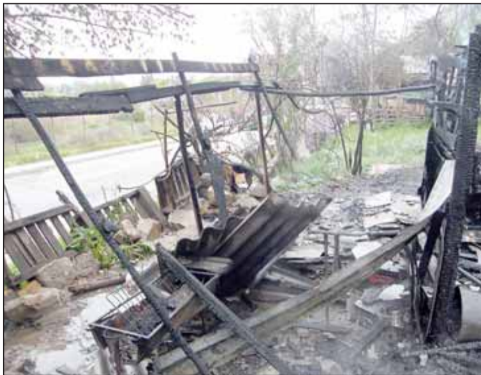
Los afectados acusan al dueño del terreno que los amenazó con incendiar su vivienda si no desalojaban el lugar tras problemas anteriores que deberán ser investigados por peritos si hubo o no intencionalidad en el siniestro. (Fotos Comandancia Bomberos)
