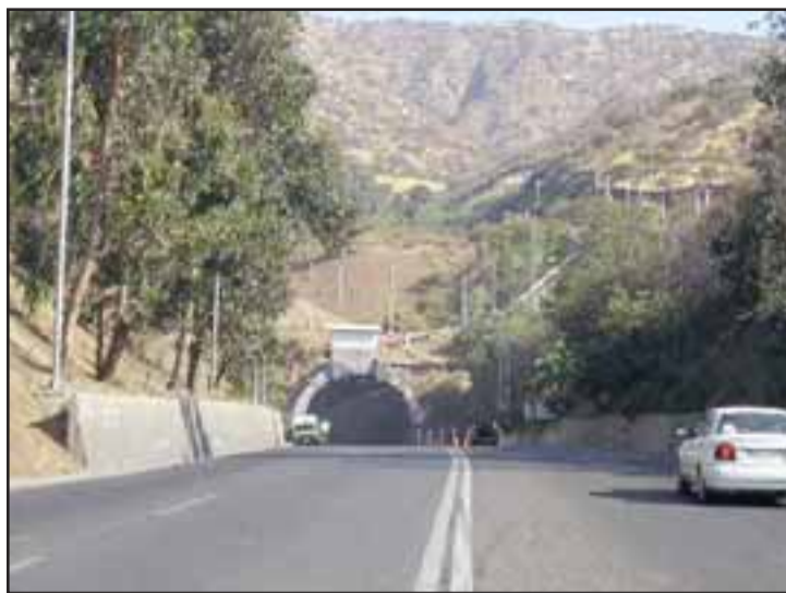
La madrugada de este miércoles 24 y jueves 25 de septiembre, el Túnel Chacabuco, mismo que comunica el Valle de Aconcagua con la Región Metropolitana permanecerá cerrado debido a trabajos de mantención.
