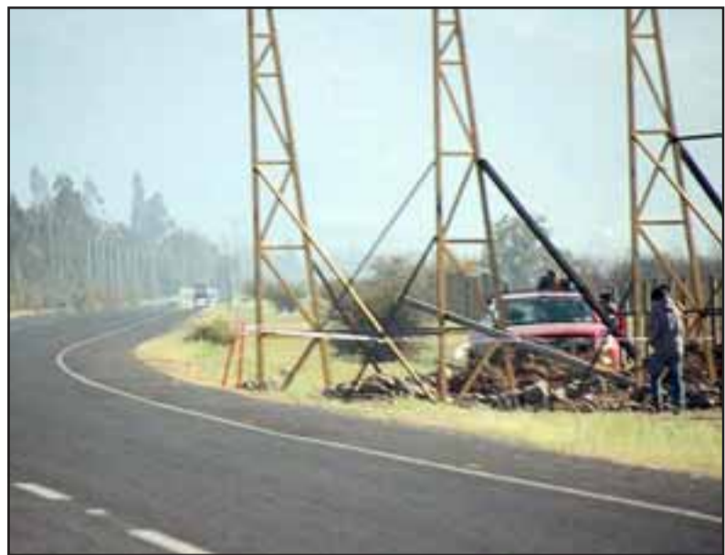
Esta enorme estructura de fierro, misma que permitirá la instalación de una señalética vial, sorprendentemente fue instalada a sólo centímetros de la carretera que une Putaendo con Cabildo, en las inmediaciones del Puente Putaendo.
