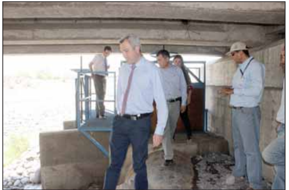
La autoridad regional llegó junto al gobernador de San Felipe al sector aledaño al Puente El Rey donde se habilitó nuevamente la conducción del agua tras la destrucción vandálica de 25 metros de conducción.
