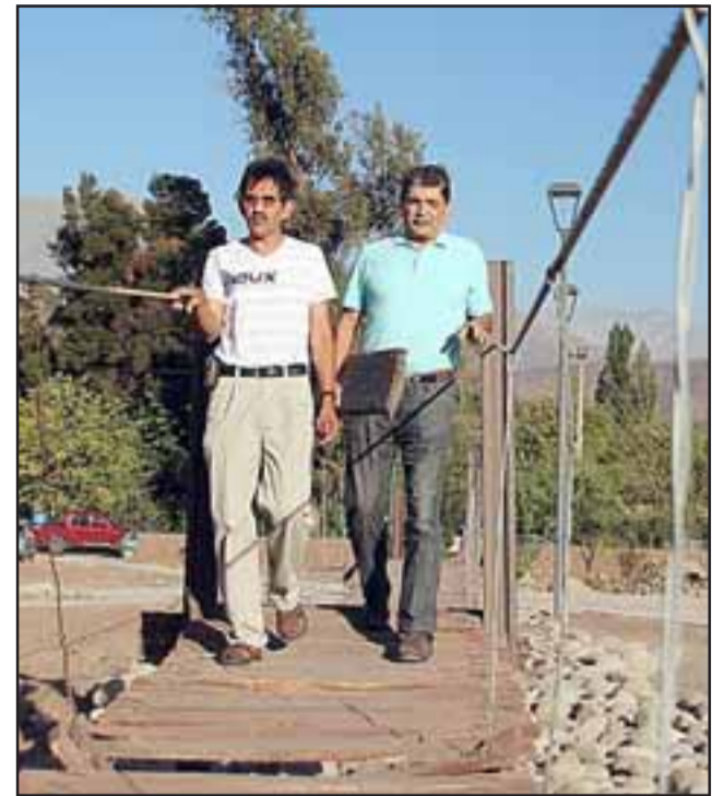
Lorenzo Salinas Lazcano, acompañado de Aldo Montenegro Ahumada, recorrieron los trabajos que hoy se realizan para restaurar el Puente Cimbra.
