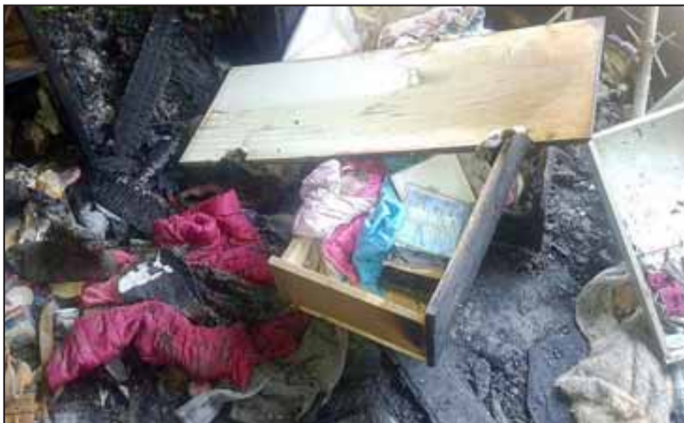
Los daños fueron considerables que afectan a dos familias que residen en la vivienda ubicada en avenida Hermanos Carrera de Villa San Francisco de San Felipe.
