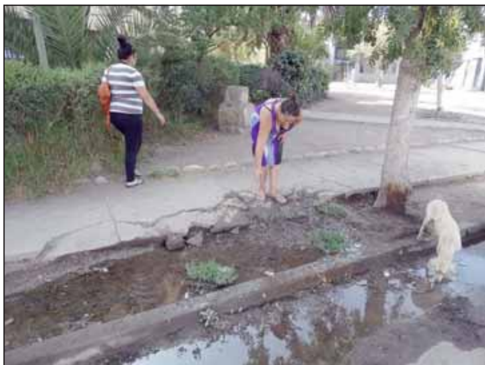
La afectada, Susana Agurto, nos muestra el lugar de la filtración de agua.
