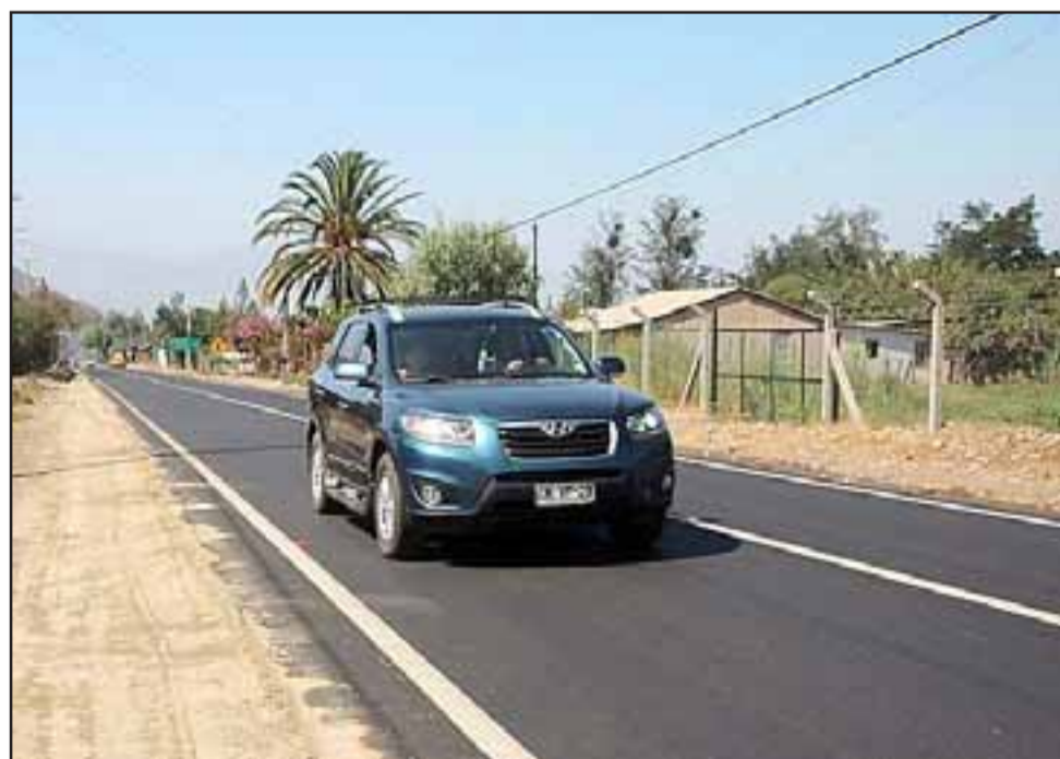
Ahora se está comenzando a rellenar las bermas de ambos costados con gravilla, que es arrojada por camiones y luego compactada para que también los automovilistas tengan seguridad al momento de ocupar la berma.
