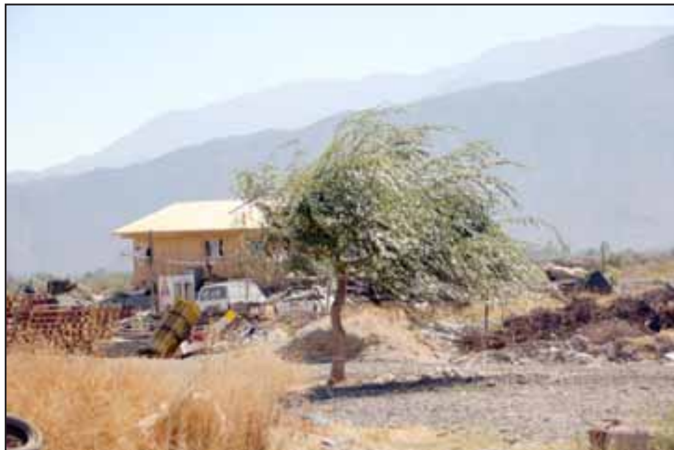
El Juzgado de Policía Local resolvió que dos viviendas ubicadas en Callejón Los Iradi de Calle Brasil, deben ser demolidas por funcionarios municipales.
