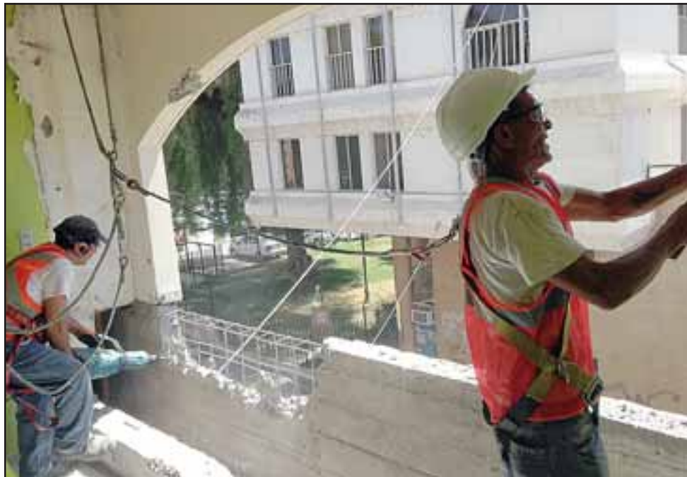
Frente a las oficinas de los concejales partieron los trabajos de construcción del nuevo ascensor panorámico que se ubicará en la parte posterior del municipio.
