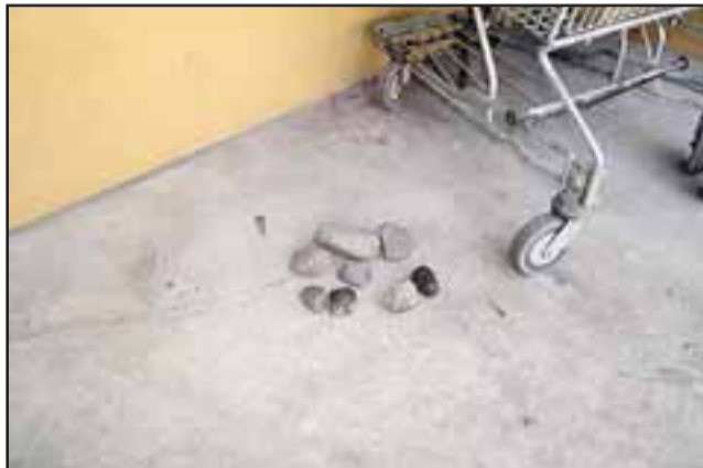
Estas son alguna de las piedras con las que los cobardes atacaron el edificio.
