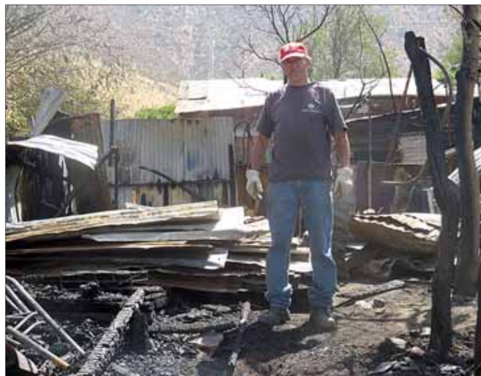
Tal como lo muestra esta gráfica, en escombros quedó reducida parte de la vivienda de este vecino llayllaino.
