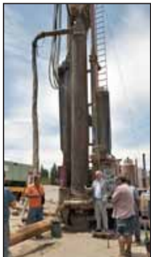
Jorge Jara destacó la rapidez en la construcción del pozo para ayudar a los pequeños agricultores.
