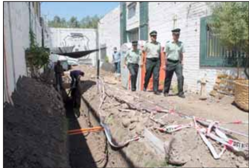
Los trabajos contemplan, en una primera etapa, la excavación del perímetro de seguridad de las unidades, trabajos que se están efectuando en la actualidad.
