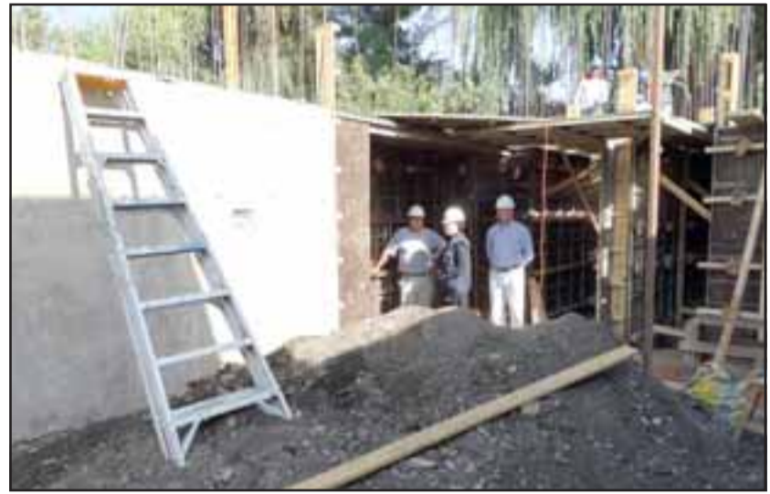
La construcción de esta sede fue inspeccionada por el Alcalde Luis Pradenas y la Directora de Obras, Loreto Galdames.
